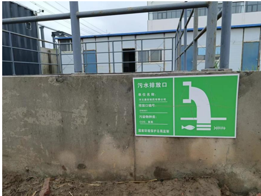
图 4.2-18 废水排放口标志牌
