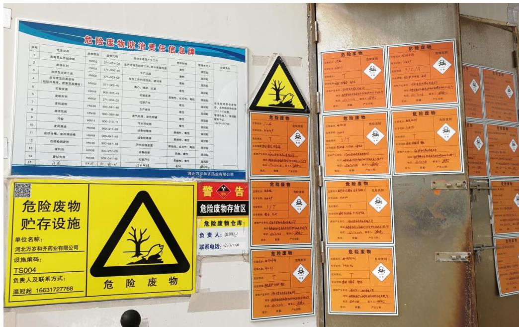
图 4.2-14 危废废物标识牌 2
